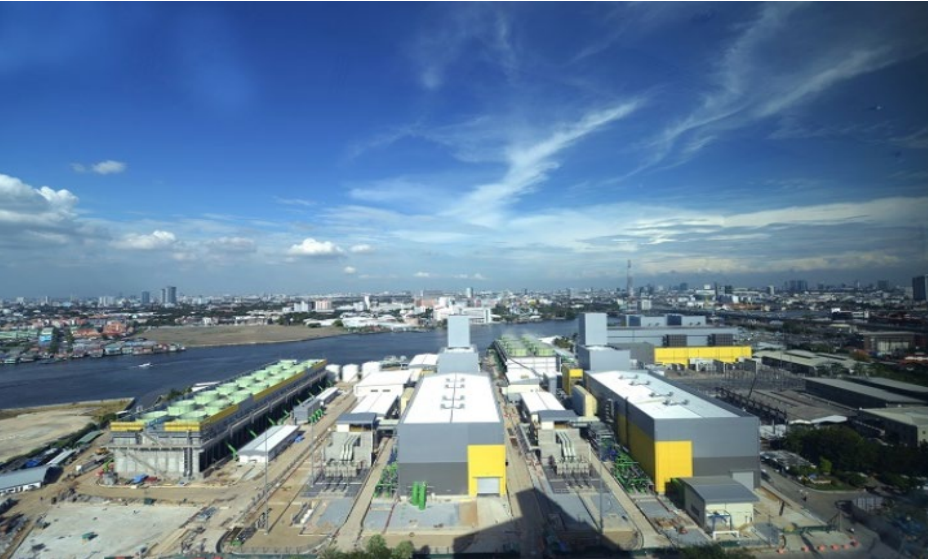
GuD Kraftwerk North Bangkok 2
