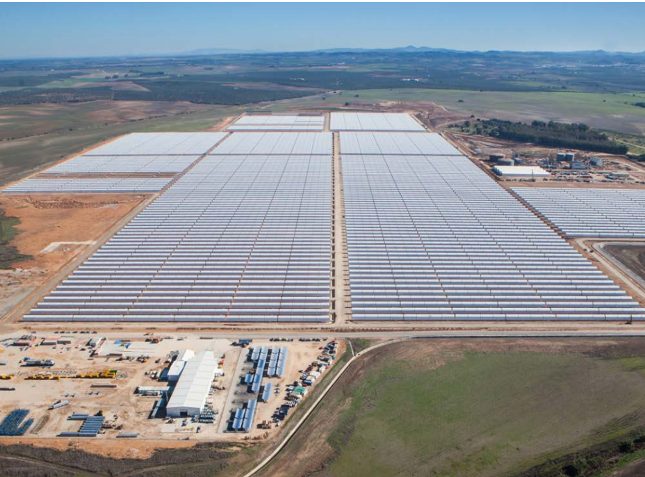
CSP-Anlage Arenales (in der Nähe von Sevilla)
