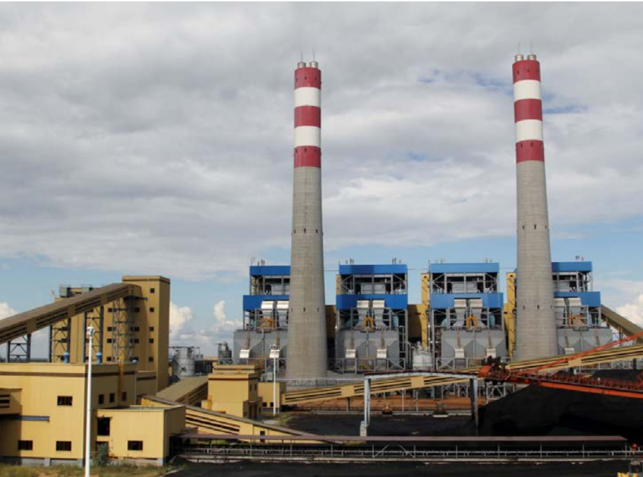
Kohlekraftwerk Morupule B mit zirkulierender Wirbelschichttechnologie
