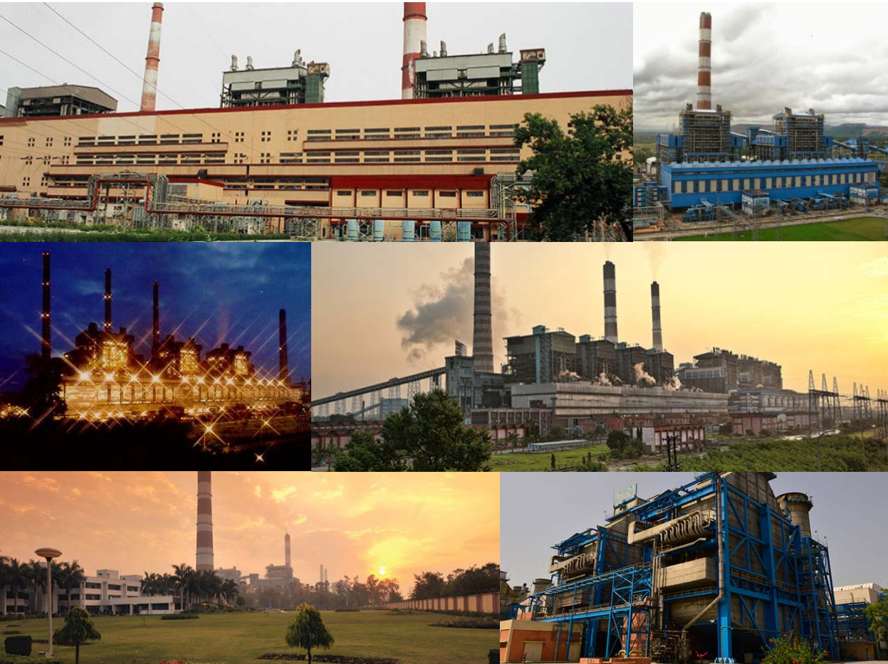
NTPC-Kraftwerke in Indien
